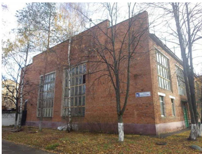
Рисунок 1.8 – Общий вид котельной №1-а АО «Одинцовская теплосеть»
