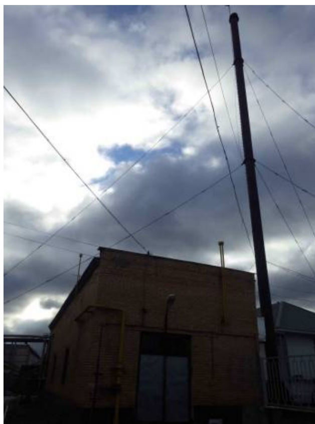
Рисунок 1.23 – Общий вид котельной Городской бани АО «Одинцовская теплосеть»
