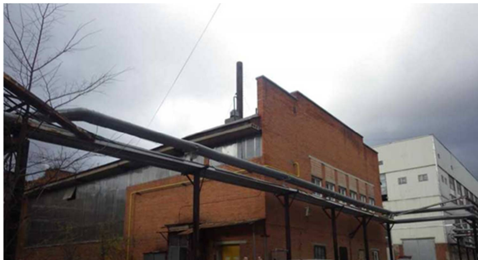
Рисунок 1.13 – Общий вид котельной №6 АО «Одинцовская теплосеть»
