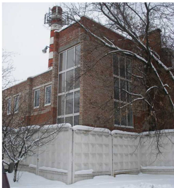
Рисунок 1.6 – Общий вид котельной №1 АО «Одинцовская теплосеть»
