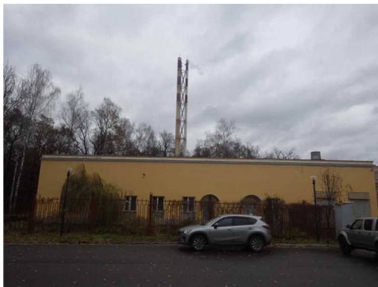
Рисунок 1.20 – Общий вид котельной «Университет» АО «Одинцовская теплосеть»
