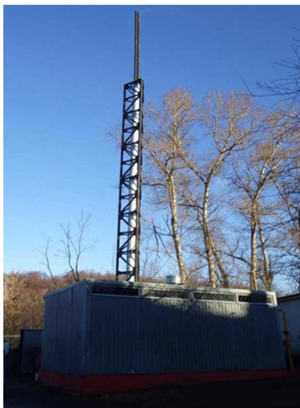
Рисунок 1.30 – Общий вид котельной с. Ромашково ОАО «РЭП «Немчиновка»
