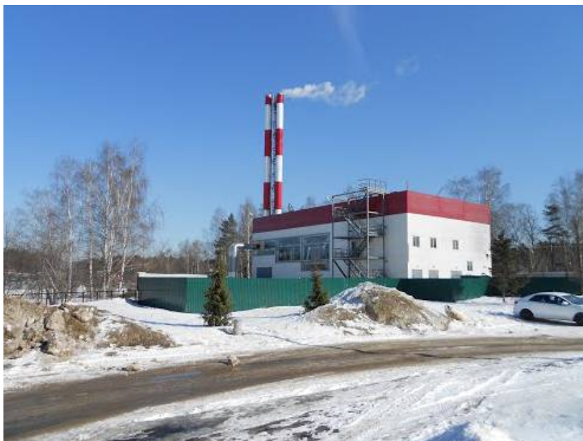
Рисунок 1.45 – Общий вид котельной №9 АО «Одинцовская теплосеть»
