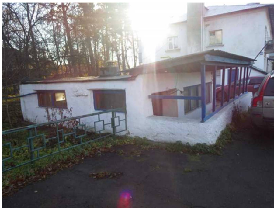
Рисунок 1.32 – Общий вид котельной с. Немчиновка ОАО «РЭП «Немчиновка»
