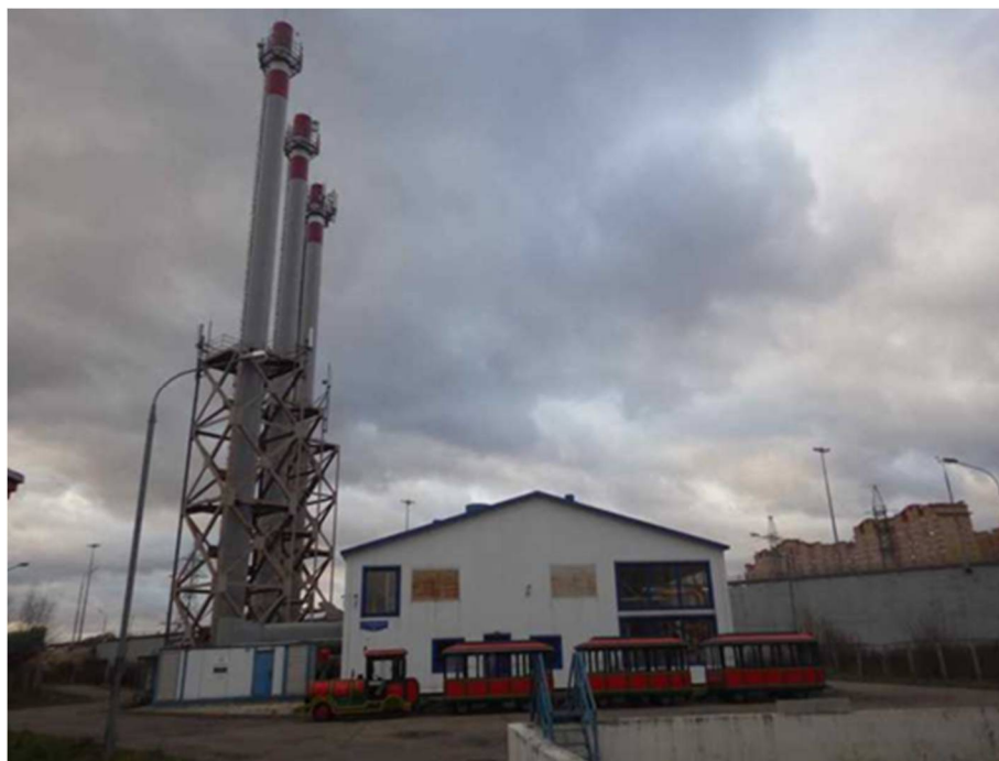
Рисунок 1.46 – Общий вид котельной №2 ООО «ЖК-Ресурс»
