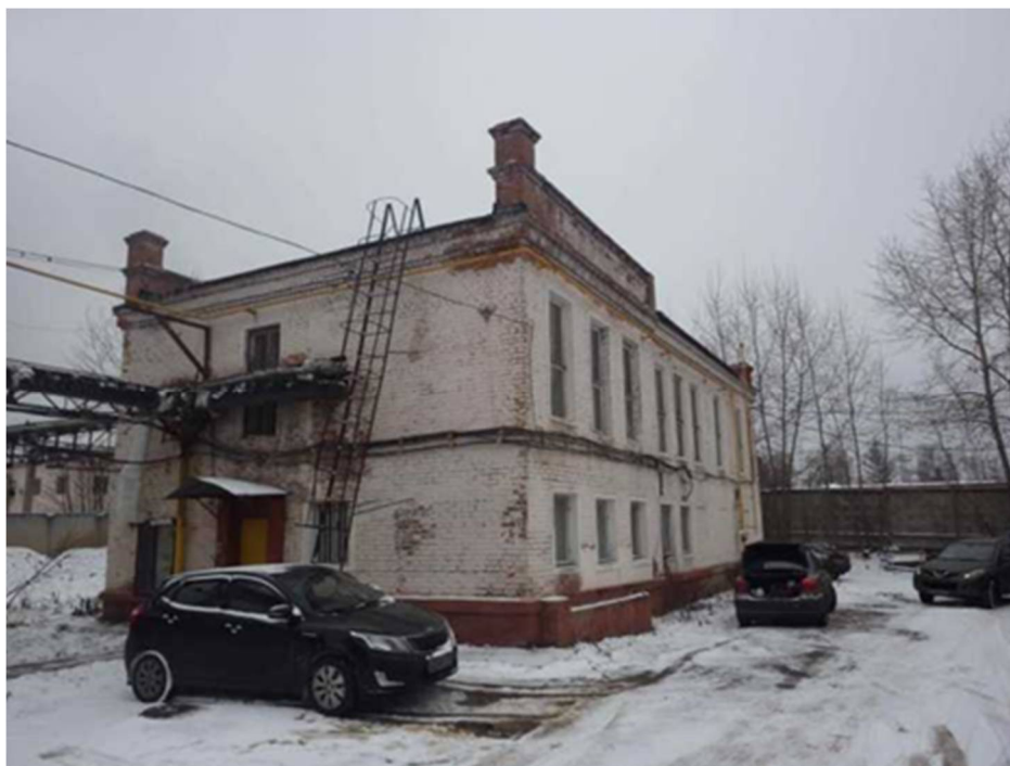
Рисунок 1.36 – Общий вид котельной №1 ОАО «ВЗОИ»
