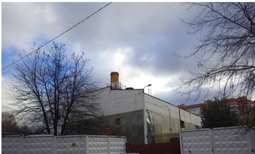
Рисунок 1.14 – Общий вид котельной №7 АО «Одинцовская теплосеть»
