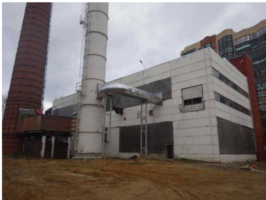
Рисунок 1.12 – Общий вид котельной №4 АО «Одинцовская теплосеть»
