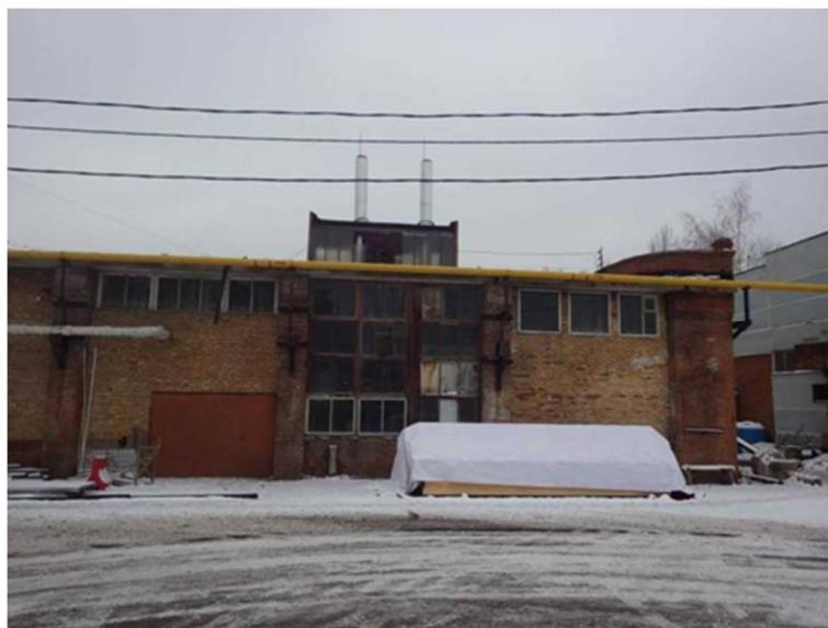
Рисунок 1.38 – Общий вид котельной №2 ОАО «ВЗОИ»
