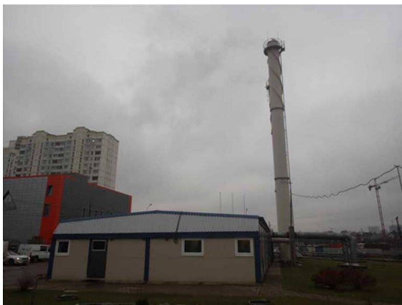
Рисунок 1.39 – Общий вид котельной «Трехгорка-1» АО «Одинцовская теплосеть»
