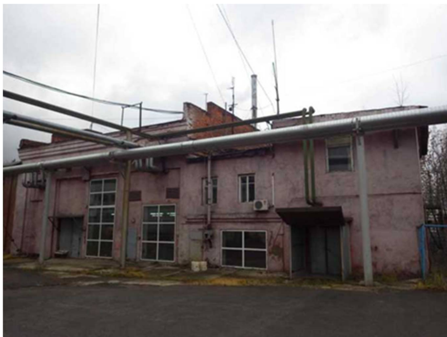
Рисунок 1.43 – Общий вид котельной ООО «БЗРИ»
