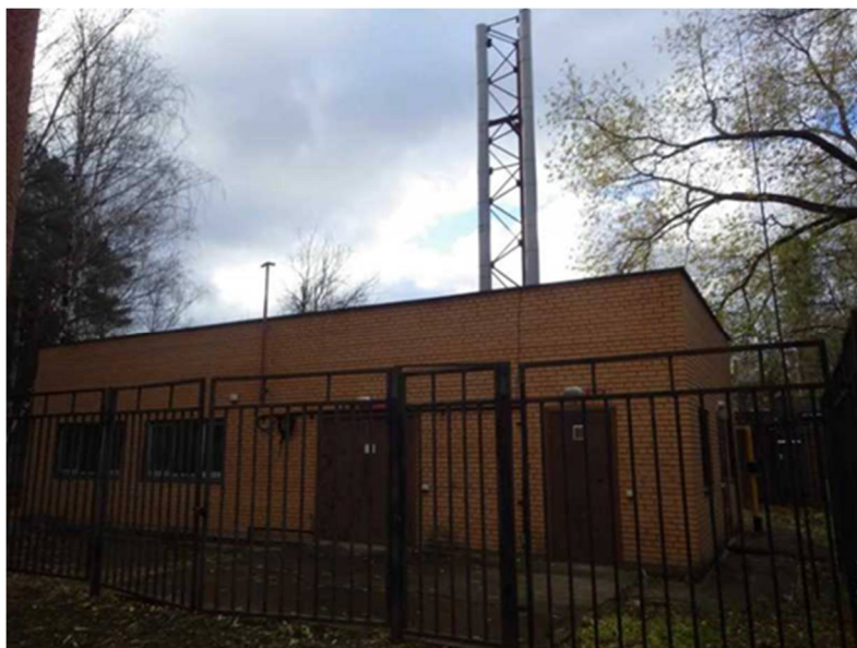
Рисунок 1.28 – Общий вид котельной п. д/о «Озера» ОАО «РЭП «Немчиновка»
