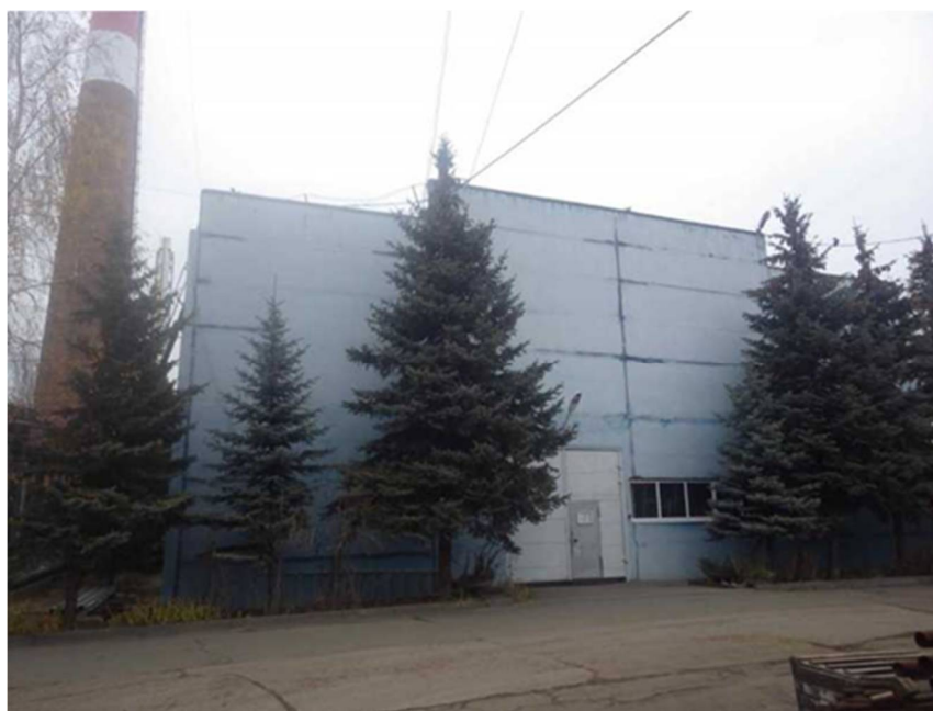
Рисунок 1.34 – Общий вид котельной ООО «МНЗ»
